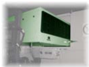
Innenteil mit Verdampfer (4,5 kW)
