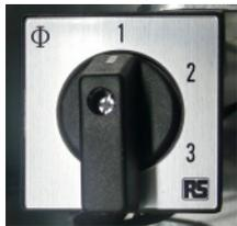
Die Luftstützanlage wird am Hauptschalter eingeschaltet. In der eluft gibt es einen Wählschalter mit vier Positionen, wobei die 1 für einen Druck von ca. 100Pa und die 4 für eine manuell vorgewählten Druck von ca. 400Pa steht. Die Positionen 2 und 3 entsprechen auch den jeweiligen Drücken von 200Pa und 300Pa und müssen manuell ausgewählt werden, abhängig von der Kissenform oder den Schneebedingungen.
